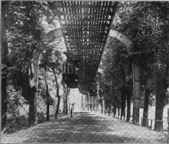
Abb. 206. Schwebebahn in Barmen-Elberfeld.
